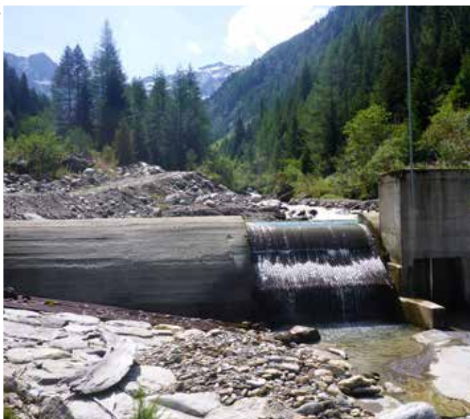
Alpenflüsse werden für die Stromerzeugung verbaut, um Wasser zu sammeln und dieses dann zu einer Turbine zu leiten.
