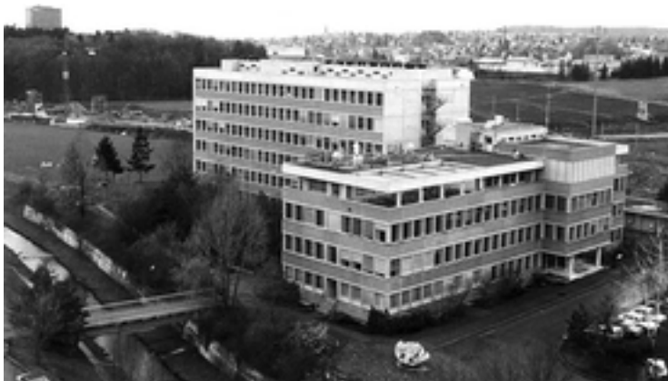
1936 gegründet, zog die Eawag 1970 in die Neubauten am Chriesbach Dübendorf, vorne das Büro-, hinten das Laborgebäude. Im Hintergrund die im Bau stehende S-Bahn. (Foto: Eawag)
