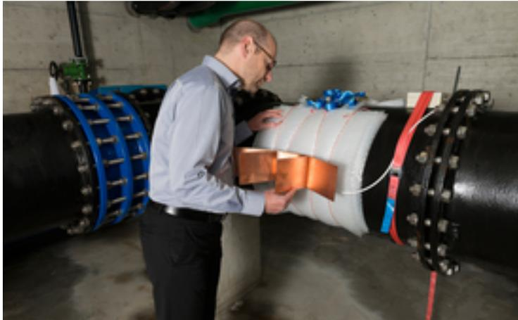
*Aus den Temperaturunterschieden – hier beim Stadtwerk Winterthur zwischen einer kalten Wasserleitung und der Umgebung – wird die nötige Energie für den Sensor und die Datenübertragung gewonnen.
