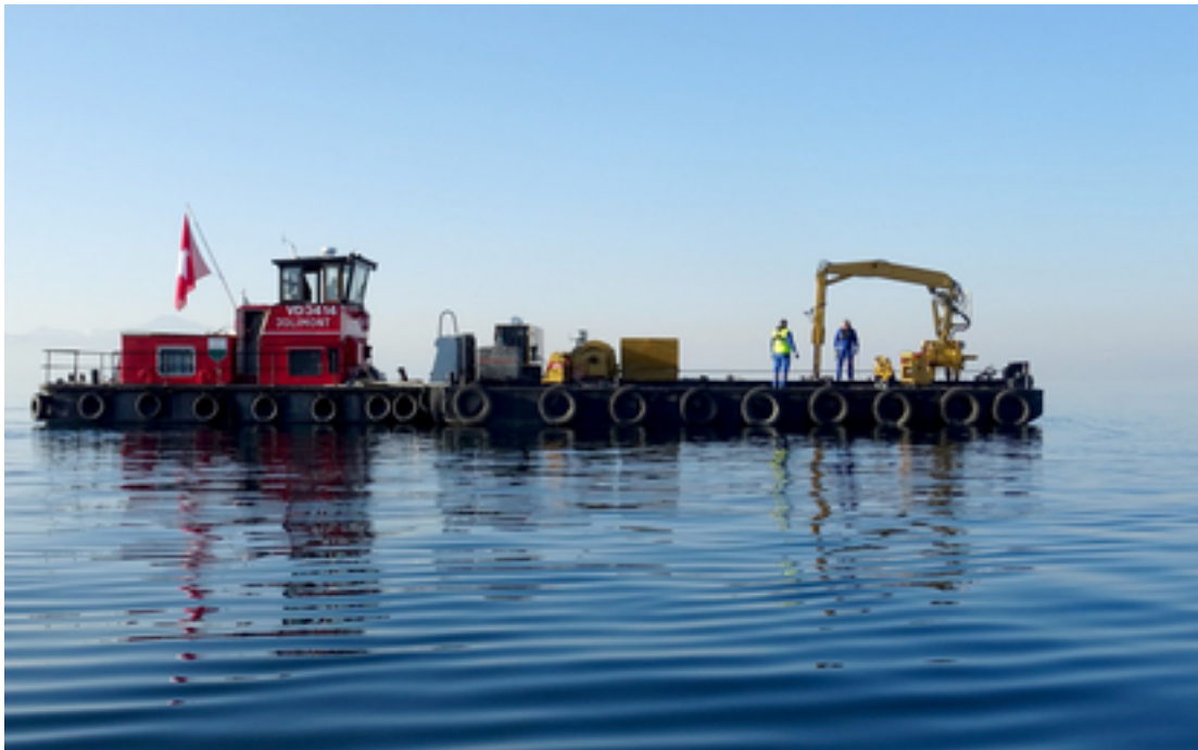
Arbeiten während der Installation der Plattform auf dem Genfersee (Bilder: Natacha Pasche, 18. Februar 2019 und 19. Februar 2019)
