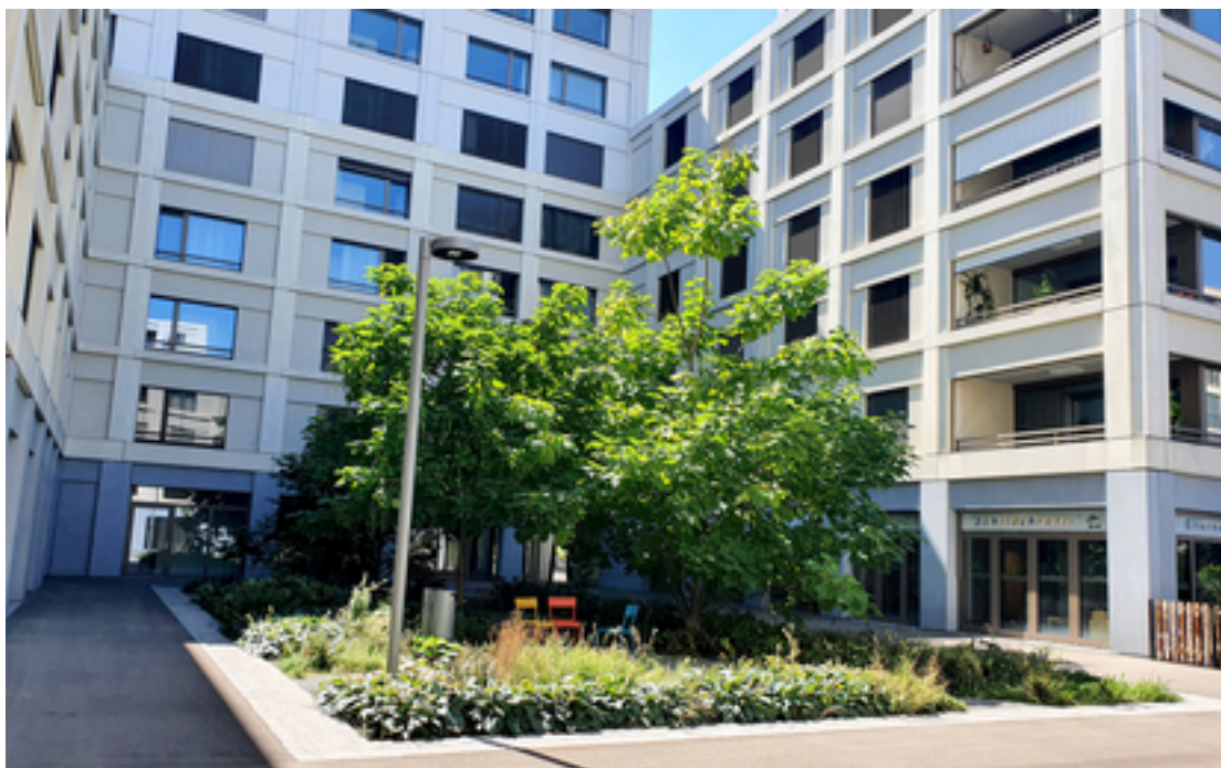
Rückhalt und Versickerung von Regenwasser in bepflanzten Gräben (links); Park mit Bäumen im Innenhof über eine Tiefgarage (Fotos: Brigitte Kisseleff, ERZ)
