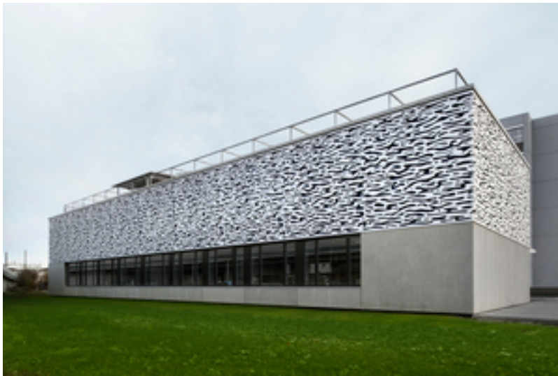
Das neue Forschungsgebäude der Eawag «Aquatikum» von der Seite zur S-Bahn (Nord). Foto: Patrik Fuchs, Andreas Müller Architekten
