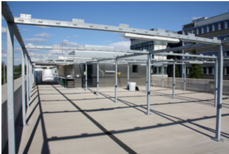
Begehbares Dach für Freiluftversuche mit Vorrichtung zum Beschatten der Anordnungen. Foto: Andri Bryner, Eawag
