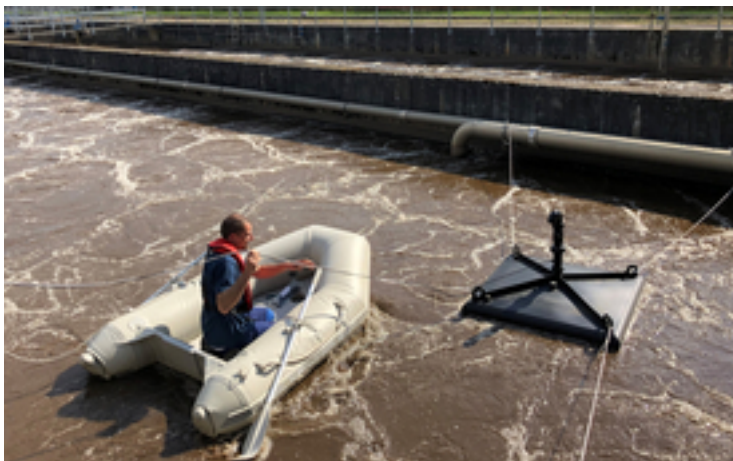
Der Eawag-Forscher Wenzel Gruber bei Wartungsarbeiten an der Messinstallation an der ARA Moossee Urtenenbach. (Bild: Andrin Moosmann, Eawag)
