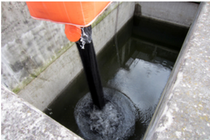
Für Versuche der Eawag wird eine Sandfilterzelle der ARA Bülach statt mit Sand mit granulierter Aktivkohle beschickt. (Foto: Eawag)
