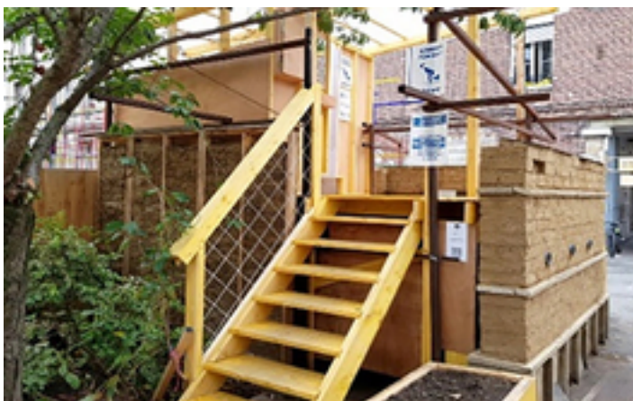
Left: Composting toilet at the Coopérative Équilibre in Geneva (Photo: Coopérative Équilibre) Right: Dry urinal prototype in Paris (Photo: Ville de Paris / Paris & Métropole Aménagement)
