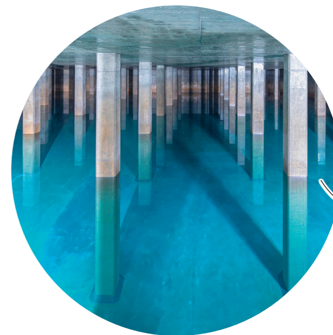
Wasserversorgung der Stadt Zürich: das Wasserreservoir Lyren in Zürich Altstetten
