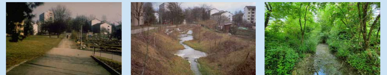
Fig. 37 : La remise à ciel ouvert de l'Hirzenbach à Schwamendingen a duré de 1987 à 1992 et a complètement transformé le paysage urbain. Là où s'étendait autrefois une chaussée (à gauche) coule maintenant l'Hirzenbach libéré de son carcan. Tout d'abord bordé d'une végétation éparse (au milieu), il est aujourd'hui entouré d'un peuplement dense d'arbres et de buissons (à droite). Photos de gauche et du milieu AWEL Zürich ; photo de droite Hektor Schnorf
