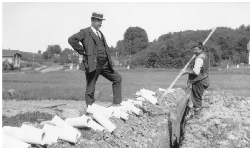
Fig. 19: La campagne suisse drainée et asséchée. À gauche : opération de mise sous terre d'un ruisseau. À droite : installation de drains agricoles. Photo de gauche archives privées de Paul Schaub-Börlin ; photo de droite Office des ponts et chaussées de Bâle-Campagne
