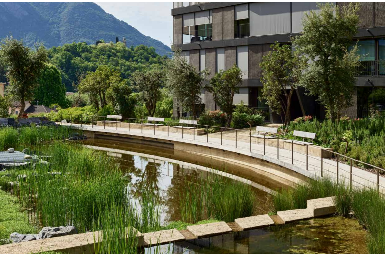
Fig. 34 : Bassin de rétention des eaux de grande valeur écologique dans l'espace urbain (Parco Casarico, Sorengo TI). Photo Igor Ponti
