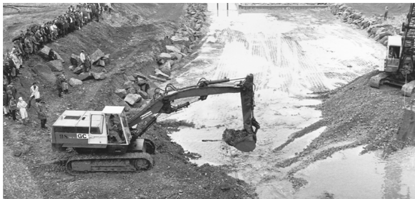
Fig. 18: En 1972, un public nombreux est venu assister à l'arrivée de la Birse dans son lit nouvellement rectifié et endigué à Aesch (BL). Pendant des siècles, la société humaine s'est efforcée d'établir une limite bien nette entre le bleu et le vert. Photo Office des ponts et chaussées de Bâle-Campagne
