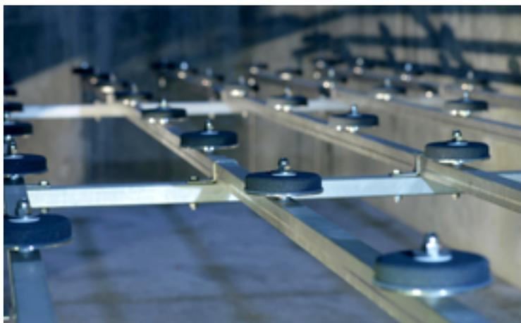
**L'ozonation est une méthode éprouvée pour éliminer les composés traces organiques de l'eau. Sur la photo: des diffuseurs d'ozone à la STEP Neugut de Dübendorf.
