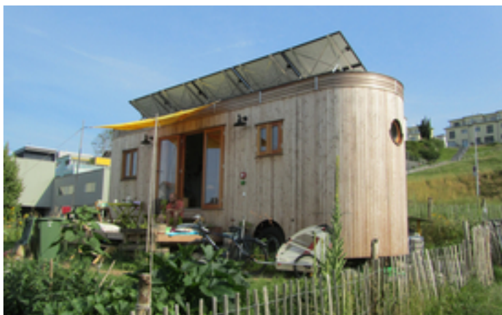
Le traitement autonome de l'urine avec récupération des nutriments est également testé dans le tinyhome
