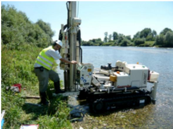
Installation d'un piézomètre pour l'observation de l'eau souterraine sur un tronçon revitalisé de la Thur à l'aide de l'engin de forage « Geoprobe »
