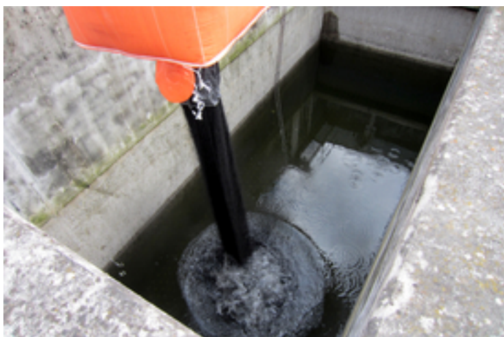
Pour des essais de l'Eawag, une cellule du filtre à sable de la STEP de Bülach est remplie de charbon actif en grains à la place du sable (photo : Eawag).
